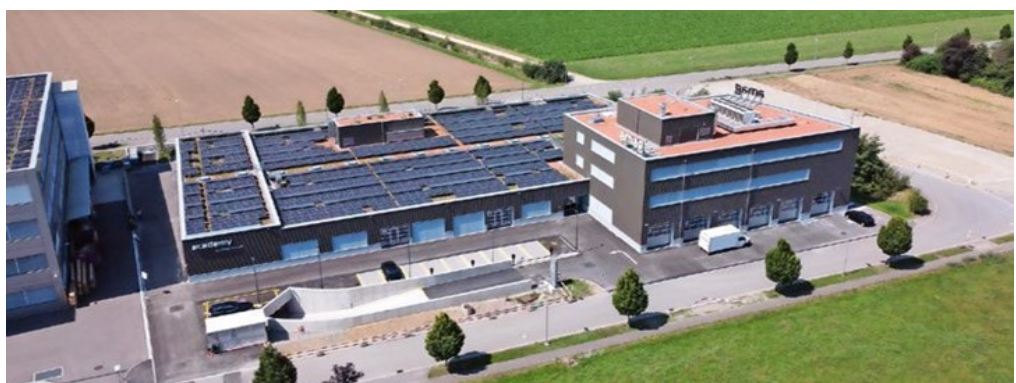
I 1'554 metri quadrati di pannelli solari dell'impianto fotovoltaico sul tetto di Amag Academy possono fornire fino a 300'000 kWh/anno di elettricità che può essere utilizzata per ricaricare le auto elettriche del parcheggio.
